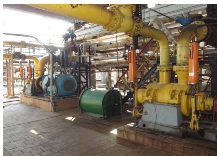
Насосные агрегаты АНМсг 450-500 на установке «Дуосол-22» после реконструкции установки
