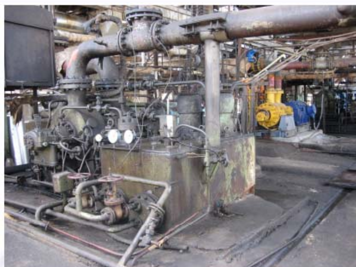
Насосные агрегаты Н-360-460сг (на переднем плане) и АНМсг 450-500 на установке «Дуосол-22»
