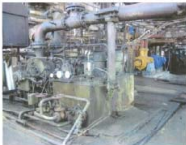
На установке «Дуосол-22» на первом плане – насос Н 360-500сг с системой «газирования» торковых уплотнений ( в настоящее время демонтирован); на втором плане – насосный агрегат АНМег 450-500 с современным уплотнительными комплексами.
