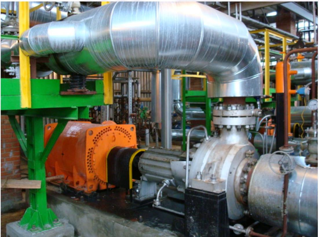
*Насосный агрегат АНКВ 340-210 в работе на реконструированной установке висбрекинга
