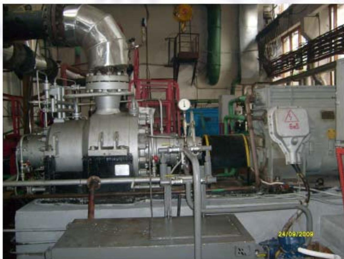
*Насосный агрегат АНДМг 600-320,  $N_{\text{эл}}$  = 800 кВт,
