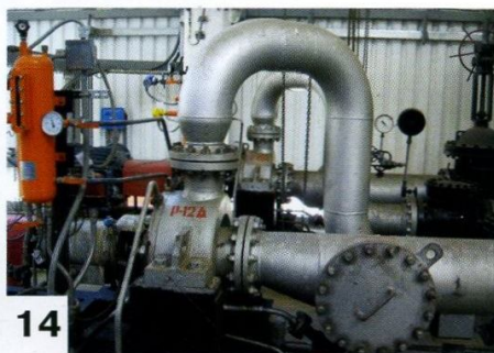
Рис. 13. Насосный агрегат АНКВ 340-210 на уст. Висбрекинга ОАО «Саратовский НПЗ».
